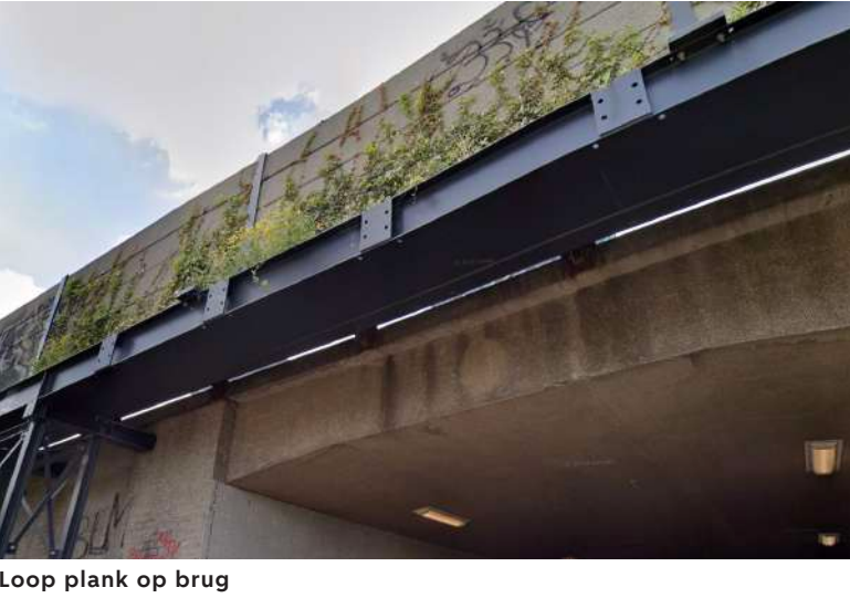
Loop plank op brug
