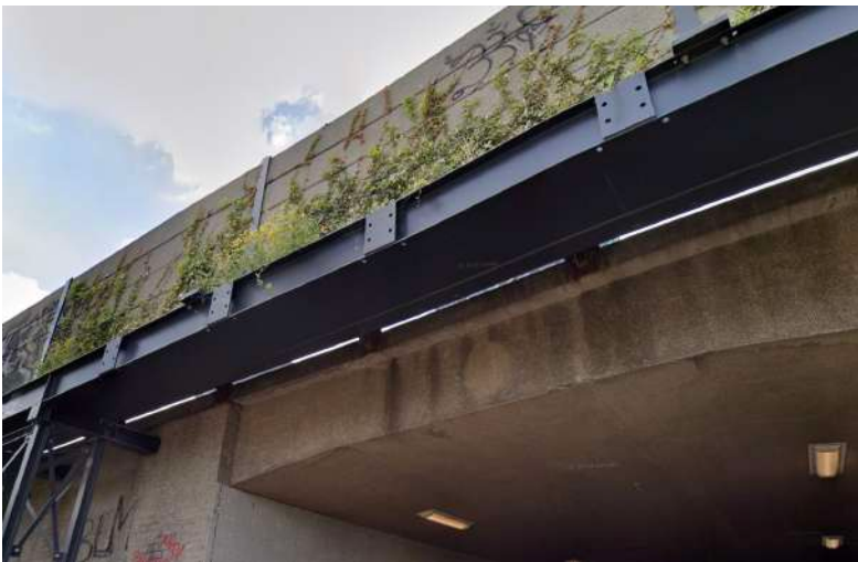
Loop plank op brug
