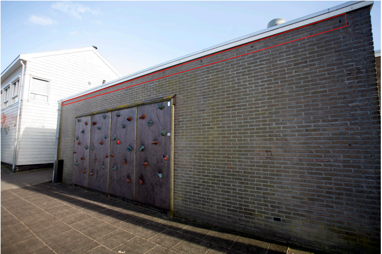
Afb.5: Spouwvoegen in een van de muren van het gymlokaal.
