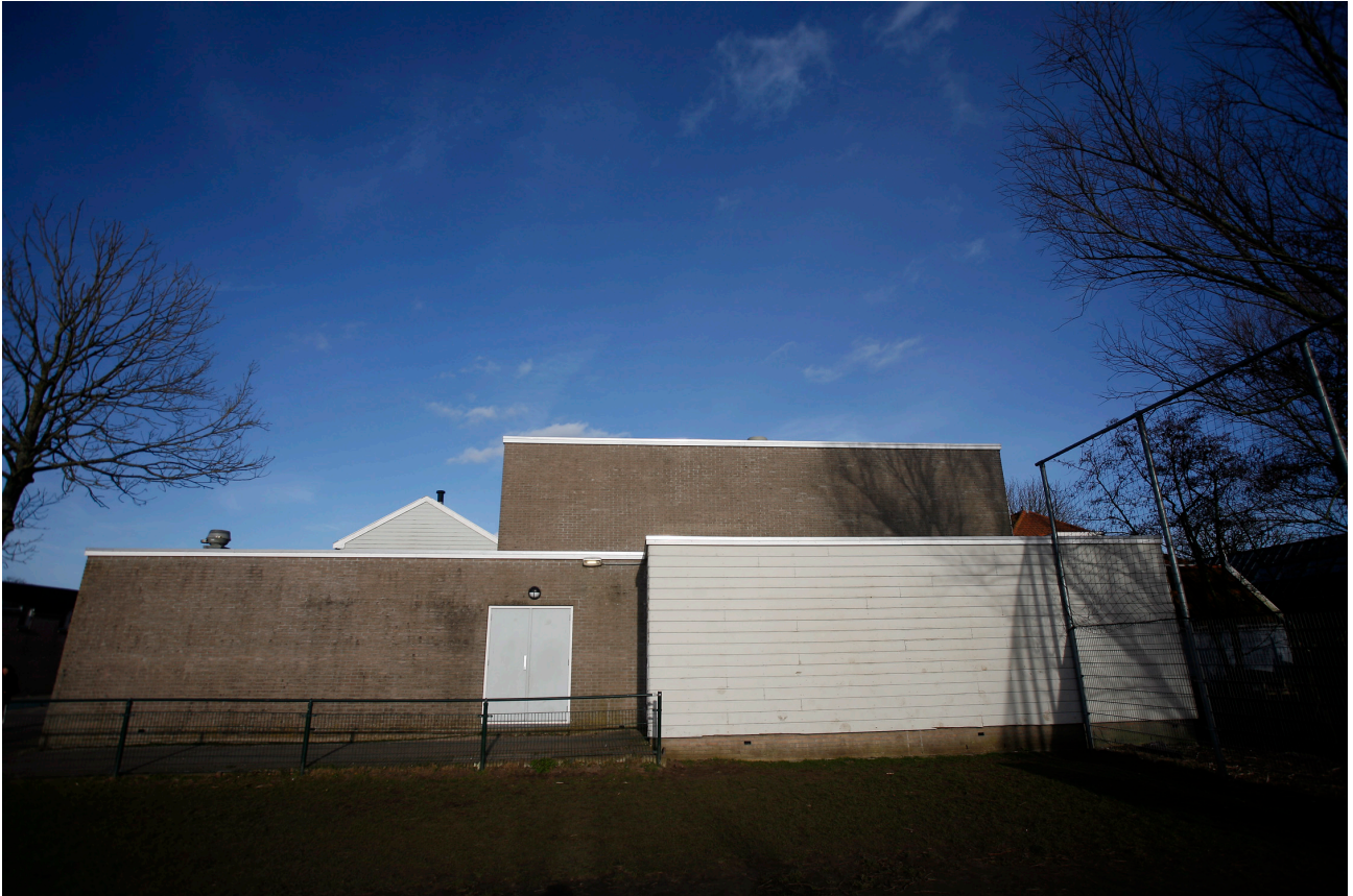
Afb.4: Het gymlokaal op nr 29.
