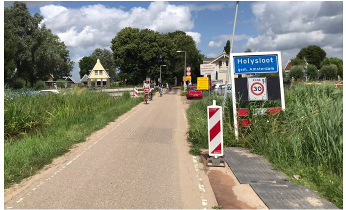
Werkzaamheden aan de weg in Holysloot
