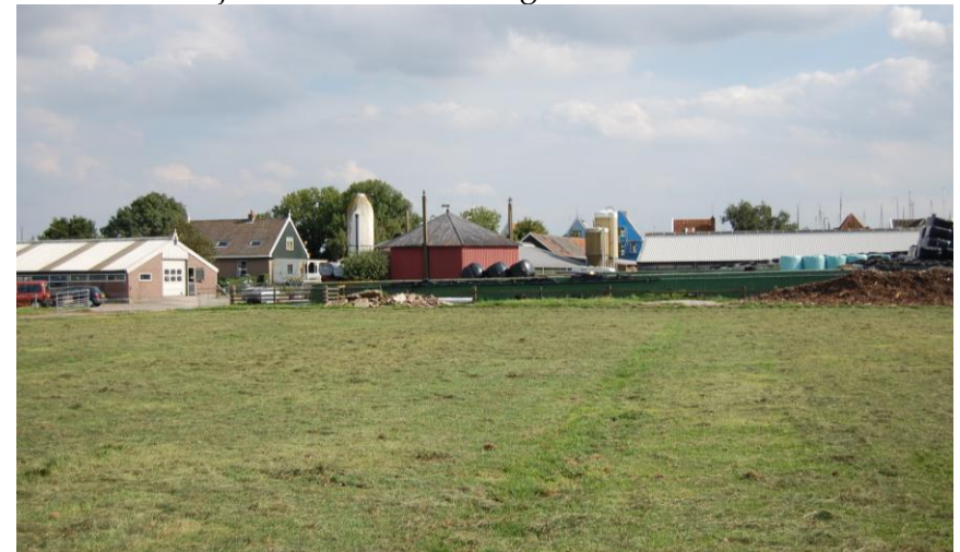
De oude bedrijfslocatie zal worden gesaneerd
